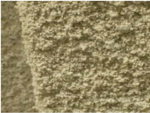
(天井の梁の角)
